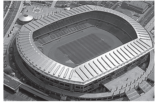
写真① 「横浜市ホームページ」より
